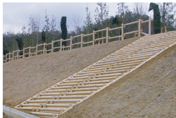
木柵と階段工
