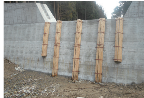
水抜き閉塞防止工
