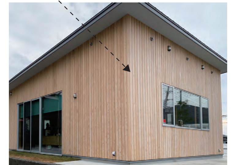
1年後のOw 国産杉 縦張り エムフェクト:クリア塗装 経年変化で色が馴染んでいきます。(源平の赤白も同様)
