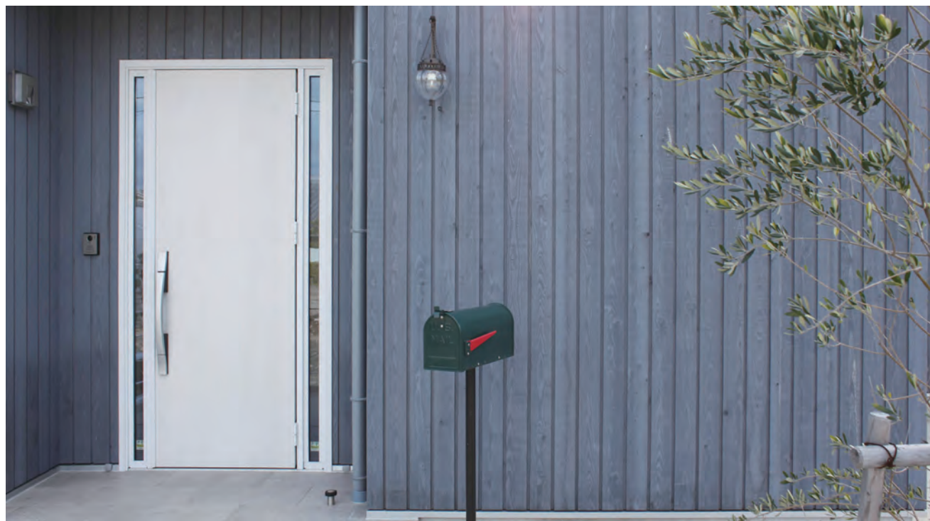
外壁:Ow 塗装:エフェクト塗装
