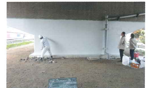
落書き防止工法
